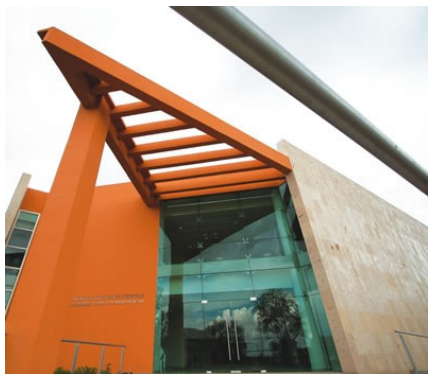
Biblioteca del Campus de Ciencias Agropecuarias.
